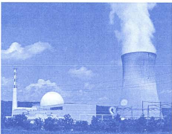
Das grösste Schweizer Kernkraftwerk in Leibstadt. (Quelle: Wikipedia, Nawi112)
